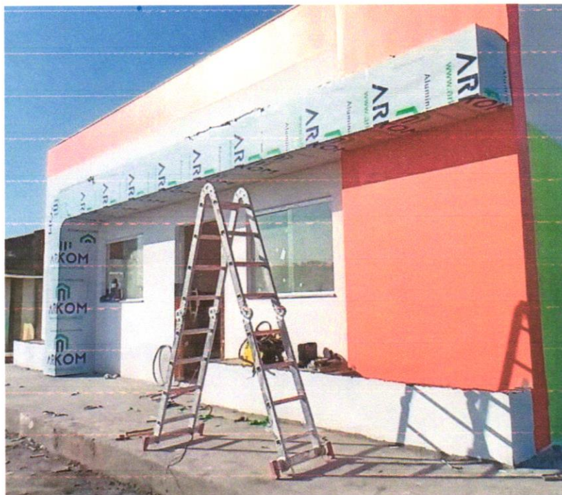
Foto 12 - Revestimento metálico em alumínio composto (Alucobond), e=0,3mm, pintura Kaynar 500 composta por seis camadas, inclusive estrutura metálica auxiliar em perfil de viga "U" de 2" - fornecimento e montagem
