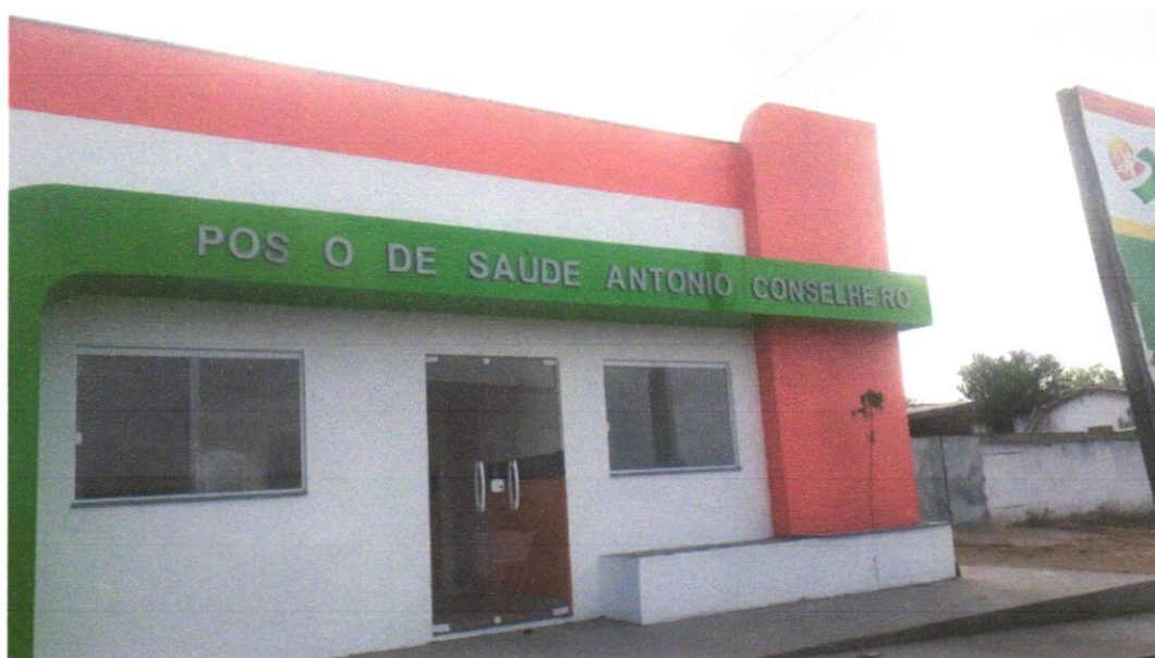
Foto 19 -Porta em vidro temperado 10mm, incolor, inclusive ferragens de fixação e instalação, exclusive puxador
