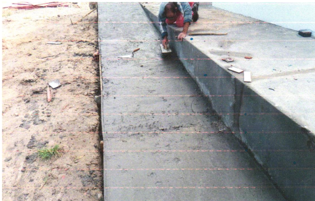
Foto 13 - Rampa padrão para acesso de deficientes a passeio público, em concreto simples F_{ck}=25\text{MPa} , despolpada, pintada em novacor, 02 demãos e piso tátil de alerta/direcional.
