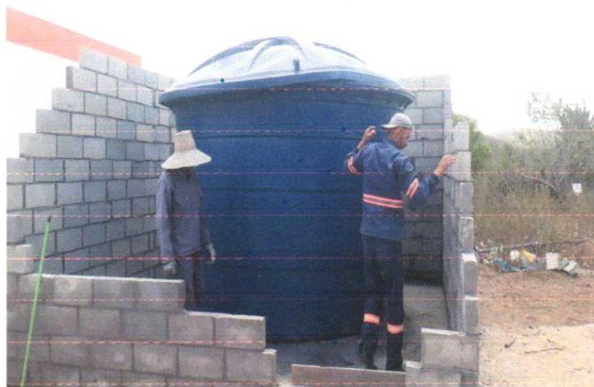
Foto 04 - ALVENARIA DE BLOCOS DE CONCRETO ESTRUTURAL 14X19X29 CM, (ESPESSURA 14 CM) FBK = 14,0 MPA, PARA PAREDES COM ÁREA LÍQUIDA MAIOR OU IGUAL A 6M 2 , SEM VÃOS, UTILIZANDO PALHETA. AF_12/2014
