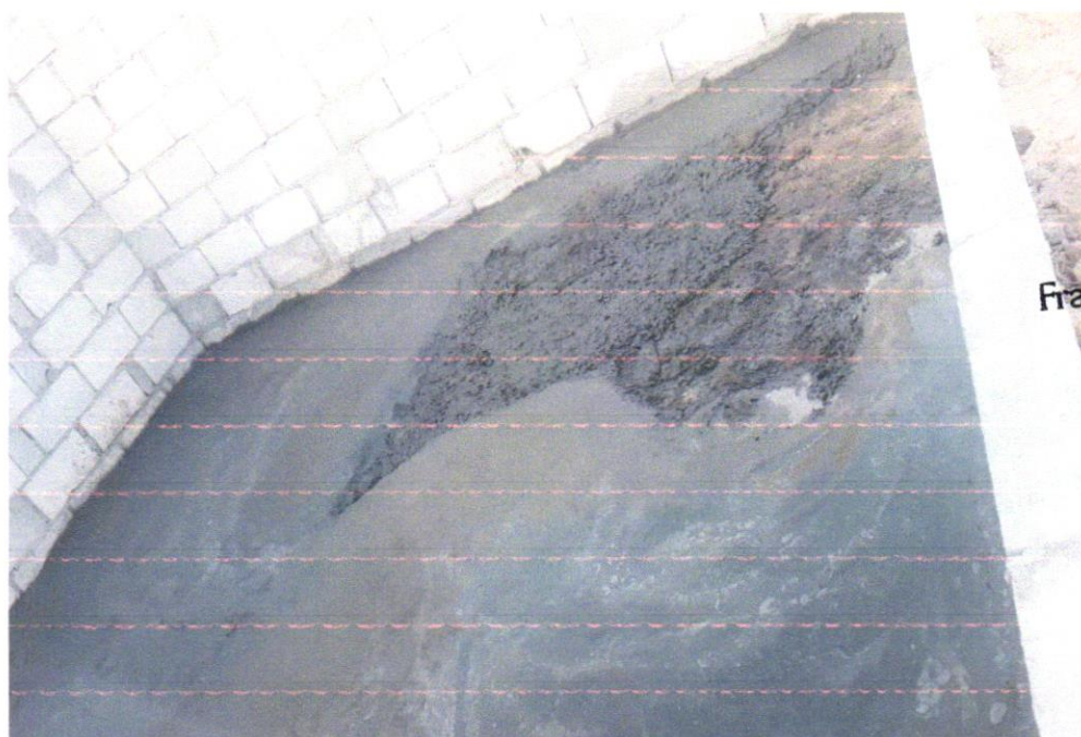
Foto 06 - Concreto simples fabricado na obra, fck=25 mpa, lançado e adensado
