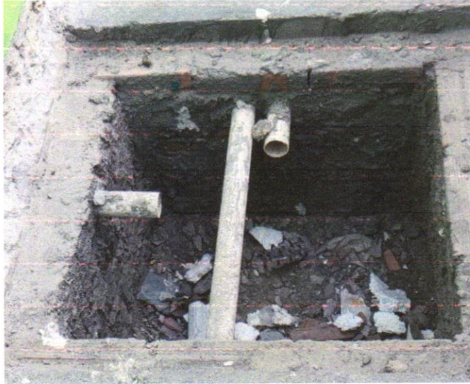
Foto 07 -Caixa de inspeção 0,30 x 0,30 x 0,40m
