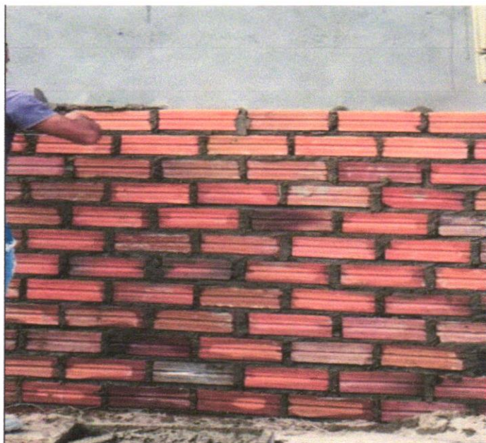
Foto 23 - ALVENARIA DE VEDAÇÃO DE BLOCOS CERÂMICOS FURADOS NA VERTICAL DE
